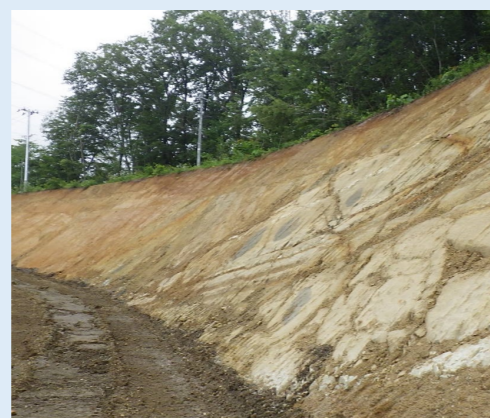
掘削地山の状況 (現在は岩盤が現れています)
