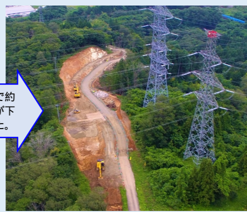
掘削地山の状況 (現在は岩盤が現れています)
