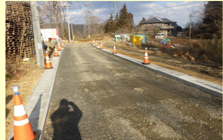
側溝設置状況
