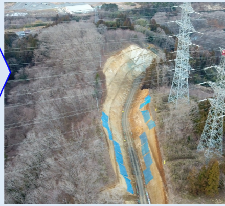
進捗写真 【南から北側を撮影】 (上空から撮影) R2.3.10
