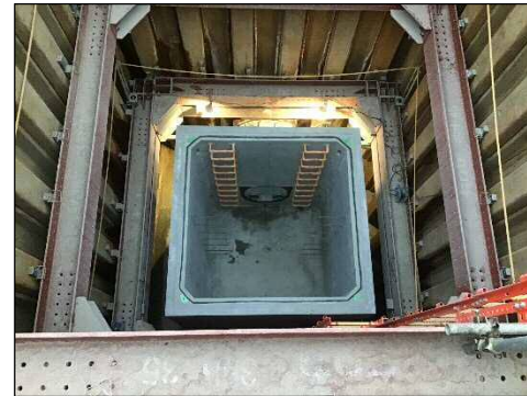
写真:マンホールの築造状況 (令和3年1月20日撮影)
