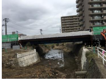
旧橋の撤去完了
