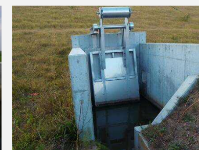
【小型水路への設置状況】
