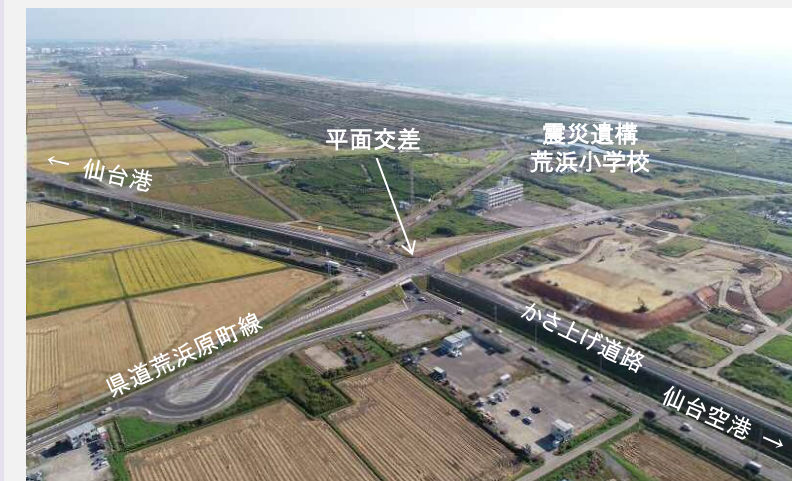
【荒浜交差点付近:令和元年9月30日撮影】
