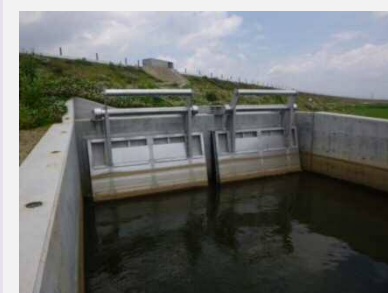
【大型水路への設置状況】
