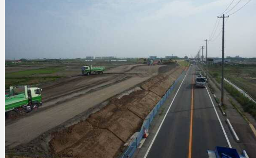
【盛土工事の施工状況】
