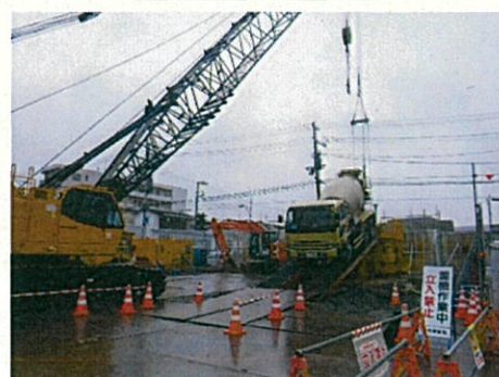
コンクリート打設
