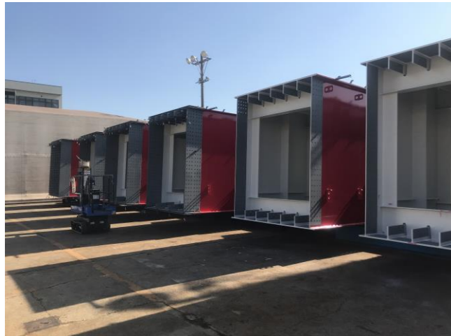
▲橋桁の塗装が一部完了しました。
