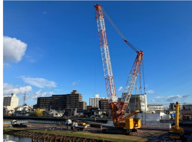
▲大型クレーンの組立が完了しました。最大150tまで吊り上げることができます。
