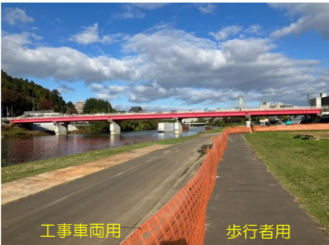
▲車両の通行帯と歩行者経路を分けるオレンジネットを設置しました。
