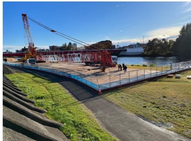
▲作業エリアを明確にするためバリケードを設置しました。バリケード内は立入禁止です。
