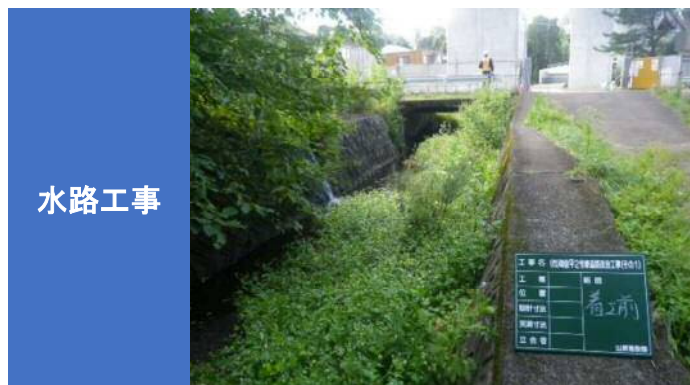
② R1.10.10 水路上流から下流に向け撮影
